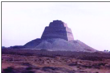
La piramide di Meidum, regnante Sneferu della 12 a dinastia, subì un crollo durante la sua costruzione. L'angolo di elevazione era di 54°.
