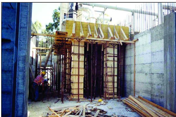
Basamento durante la costruzione.
