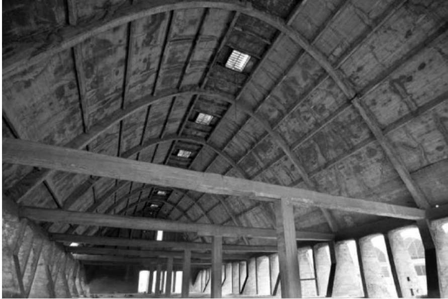
Figura 5.15 - Vista interna del Paraboloide in cui sono evidenti le travi longitudinali che lo attraversano tutto in lunghezza 1 .
