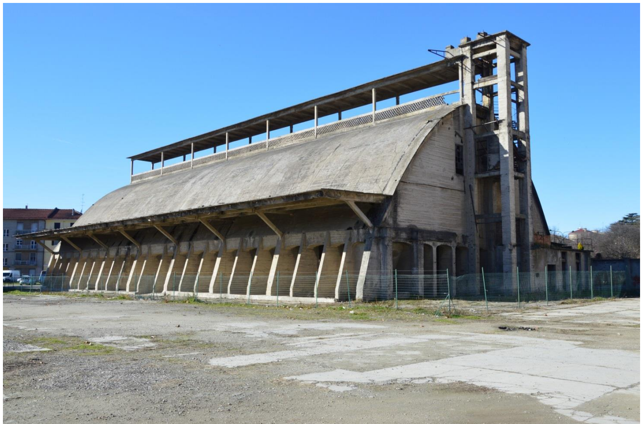
Figura 1.1 - Vista dall'esterno del Paraboloide di Casale Monferrato.
