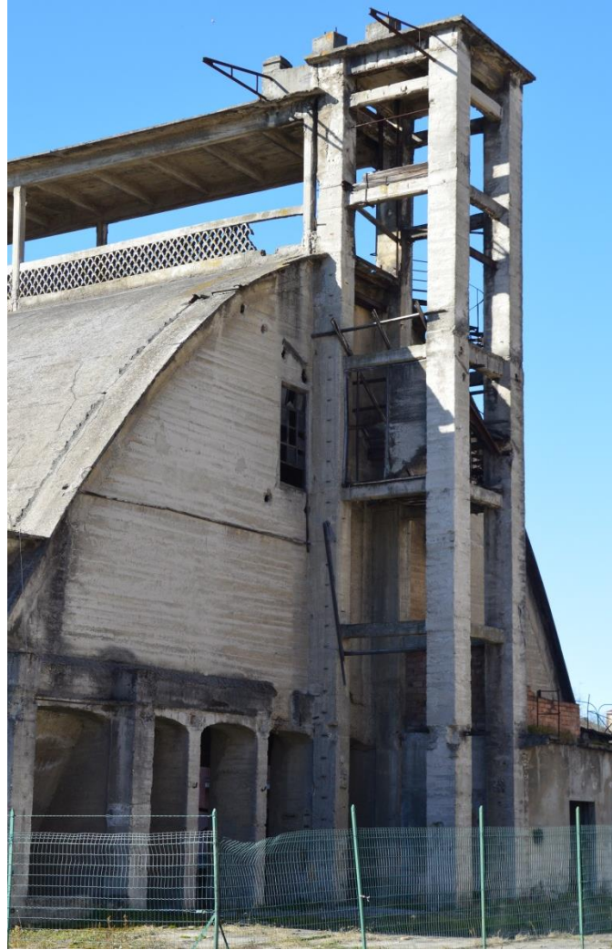
Figura 2.24- Particolare della struttura che veniva utilizzata per lo spostamento dei carichi nel Paraboloido.
