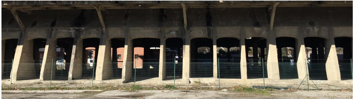
Figura 2.16 – Vista laterale di una pilastrata in cui si può notare l'alternanza di due pilastri secondari (più sottili) dopo ogni pilastro principale (più spesso).
