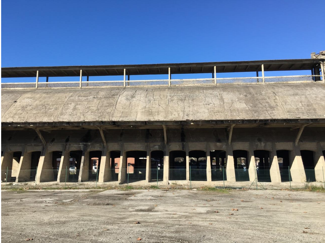
Figura 2.12 – Vista laterale del Paraboloid
