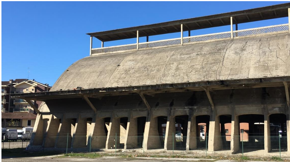
Figura 5.12 - Foto del Paraboloido di Casale in cui si può notare come sul guscio non c'è nessuna nervatura che sporge verso l'esterno
