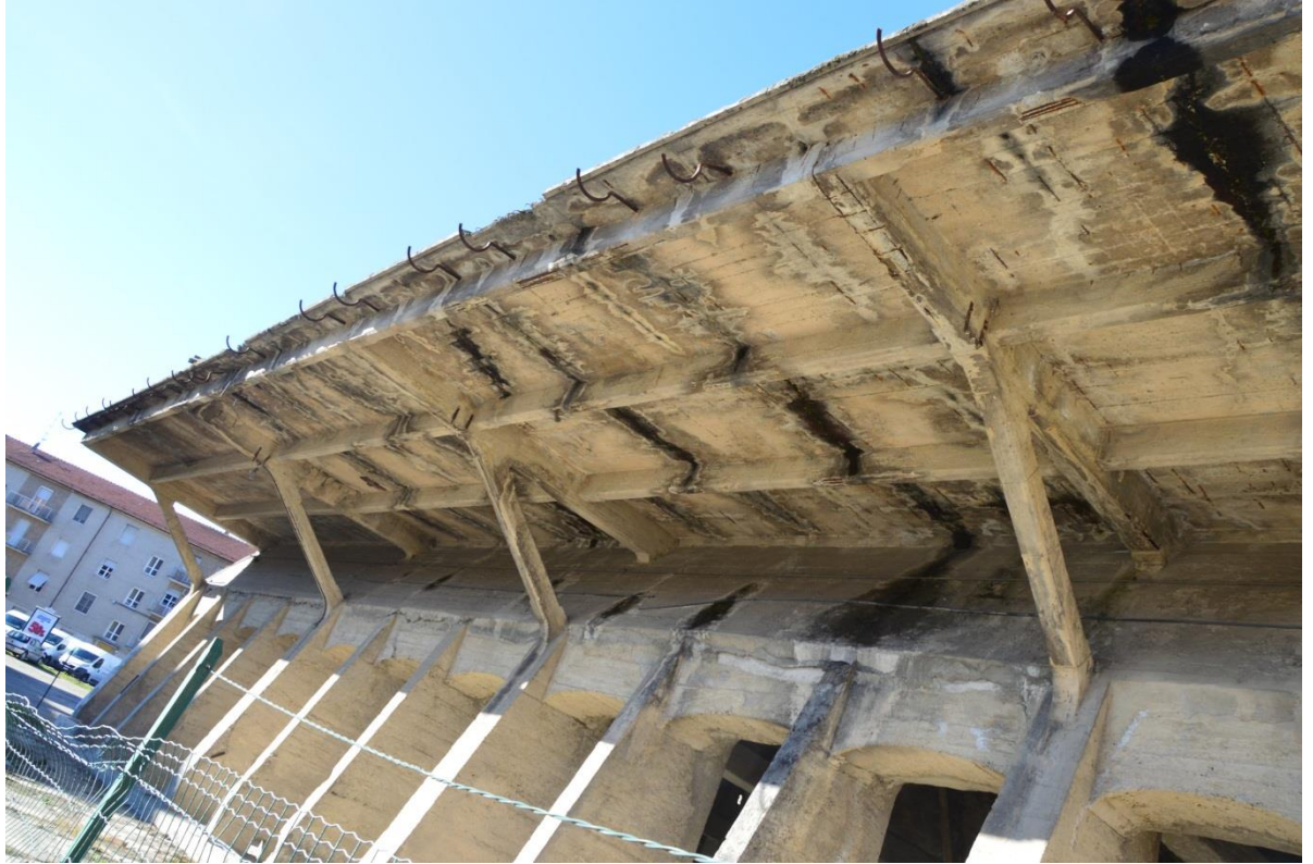
Figura 5.19 - Fotografia esterna del Paraboloide in cui è possibile notare i travetti su cui si appoggia una delle due pensiline laterali.
