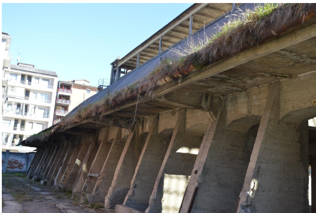
Figura 2.11 – Pilastrata e pensilina del lato Ovest della struttura.
