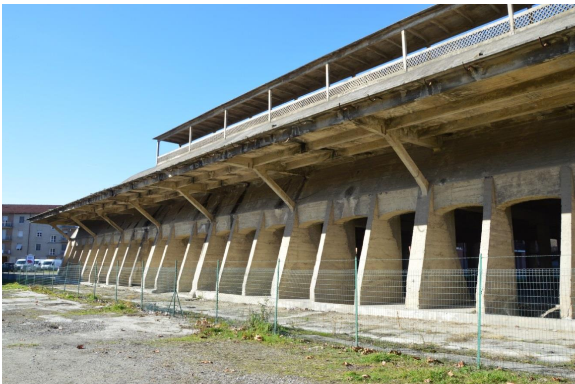
Figura 2.9 – Vista laterale della struttura, con pensilina e pilastrata sinistra in primo piano
