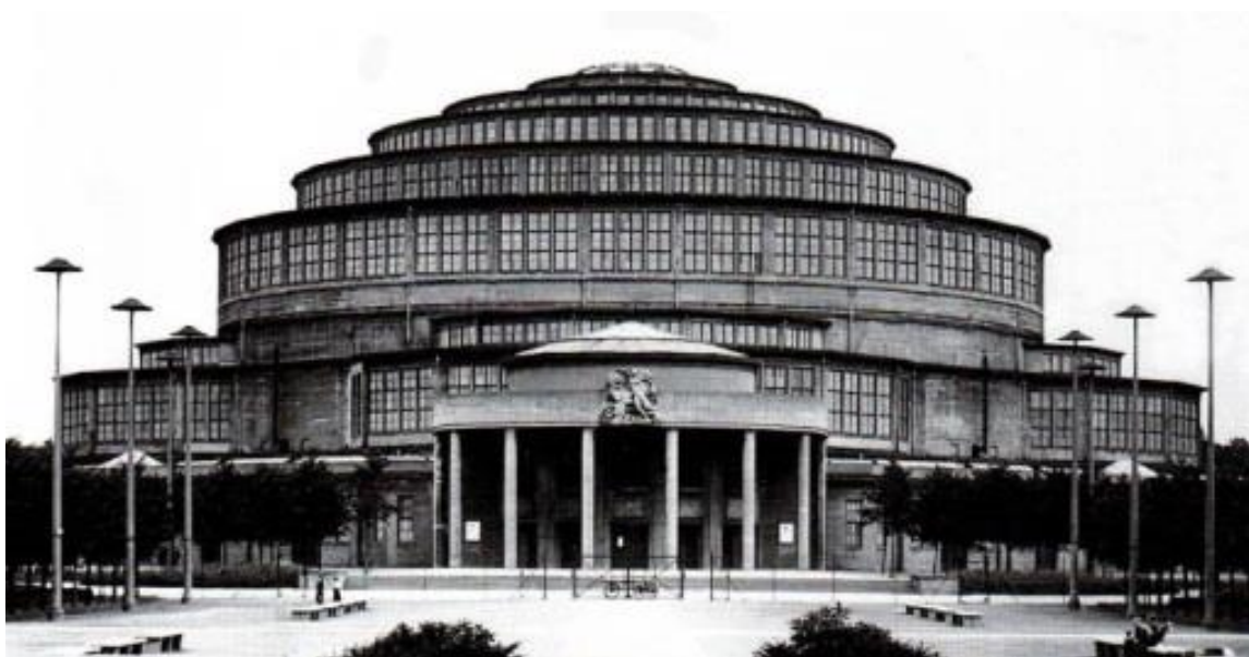
Figura 1.3 - Esterno della Sala del Centenario (Hala Stulecia, Max Berg, 1911-13) a Wrocław (Polonia). 2
