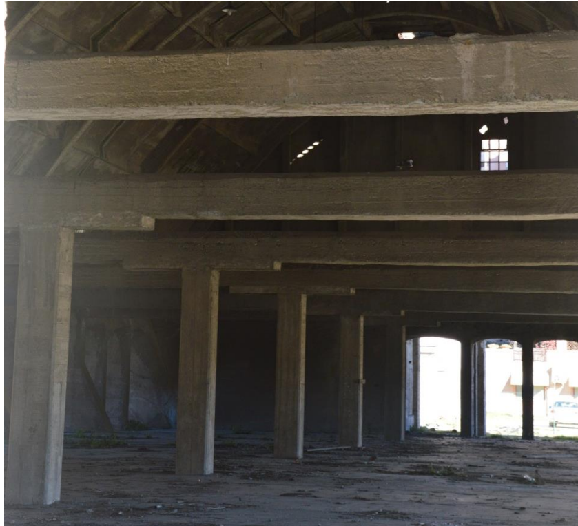
Figura 2.17 - Vista dell'interno del Paraboloido in cui sono evidenti le travi orizzontali intermedie con i pilastri che le sorreggono al centro.
