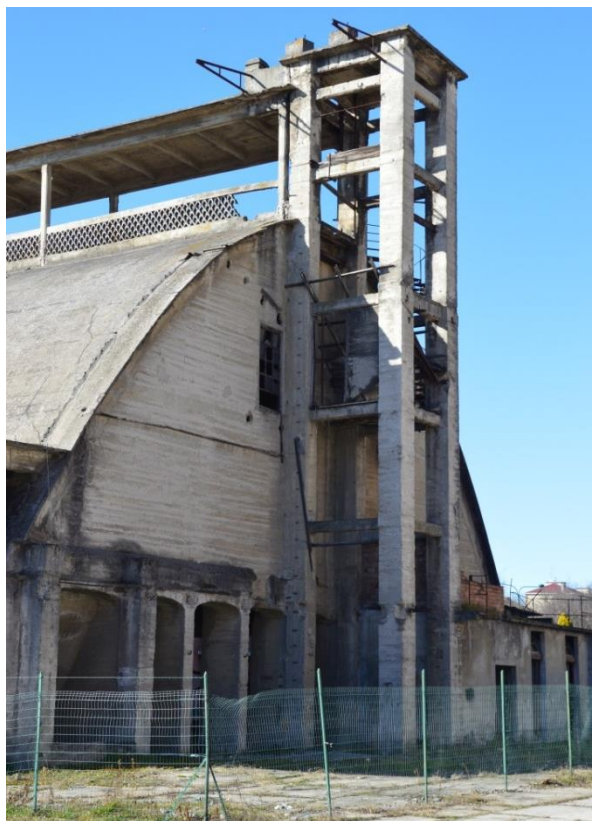
Figura 2.10 – Prospetto Sud della struttura visto dall'esterno.
