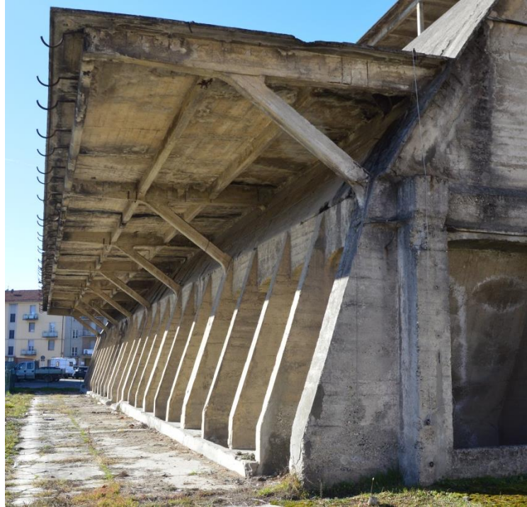
Figura 5.13 - Foto interna del Paraboloido di Casale in cui si può notare la forma particolare dei pilastri.
