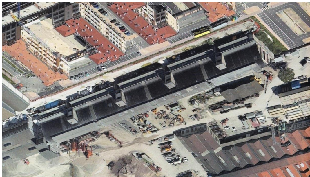
Figura 2.49 – Vista esterna del Paraboloide di Ravenna 1 .
