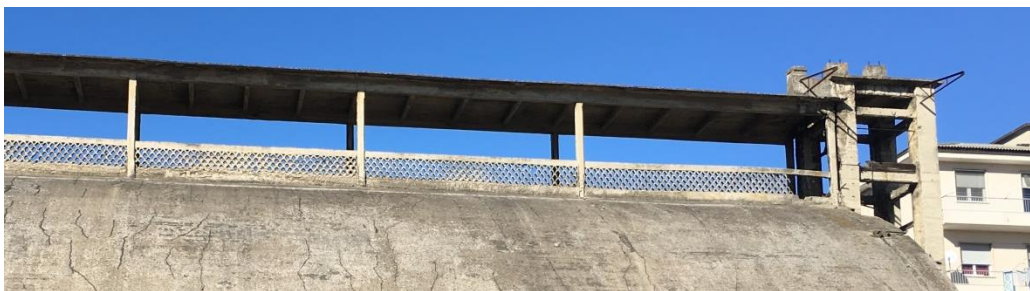
Figura 5.21 - Immagine esterna della passerella superiore.
