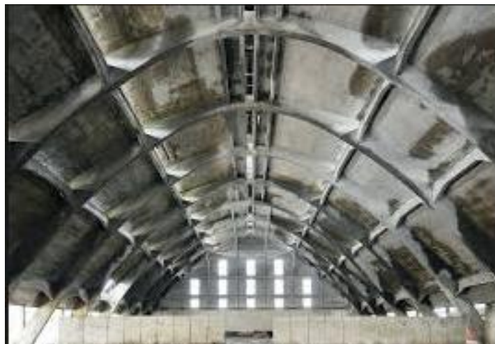
Figura 2.38 - Veduta interna del Paraboloide delle Saline di Volterra. 2
