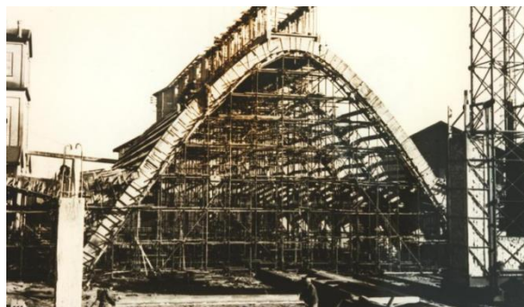
Figura 7.7 - Costruzione del Grande Paraboloido di Cerea.
