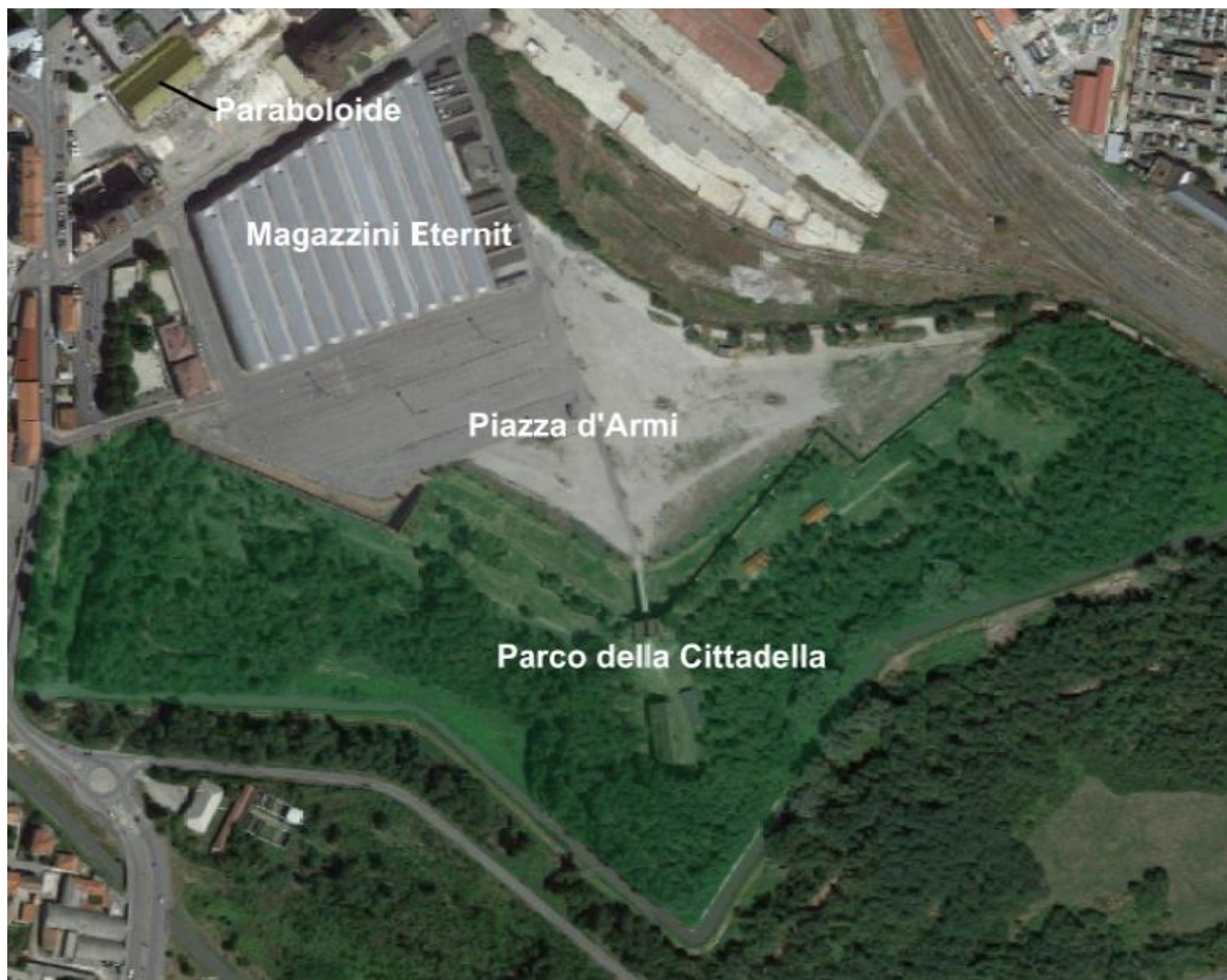
Figura 2.5- Veduta aerea di Piazza d'Armi e del Parco della Cittadella.
