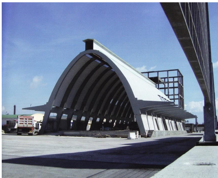
Figura 2.47 - Vista esterna del Paraboloide di Napoli 1 .
