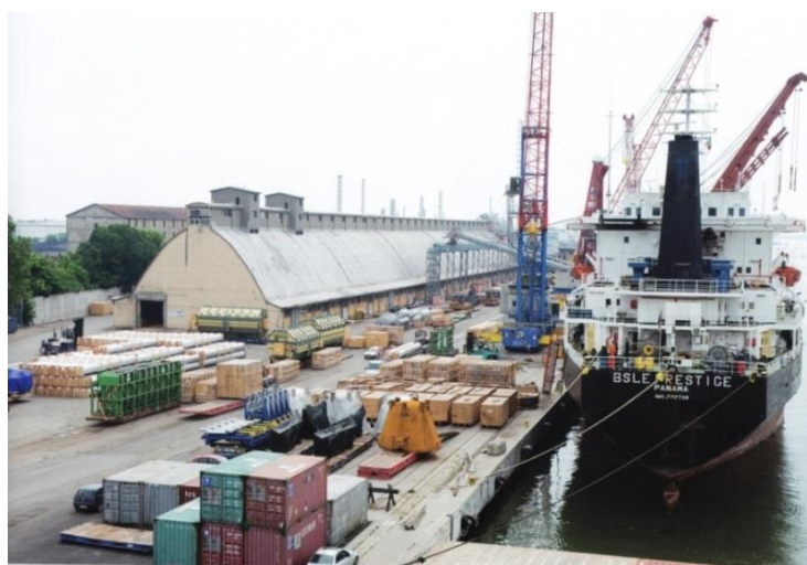
Figura 2.39 - Veduta esterna del Paraboloide di Porto Marghera a Venezia.
