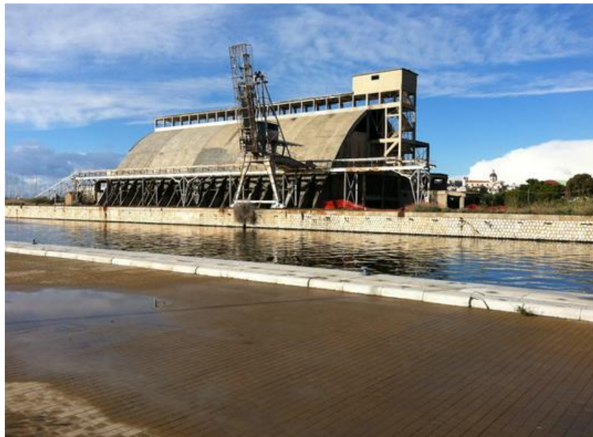
Figura 2.34 - Veduta esterna del Paraboloido di Cagliari. 1
