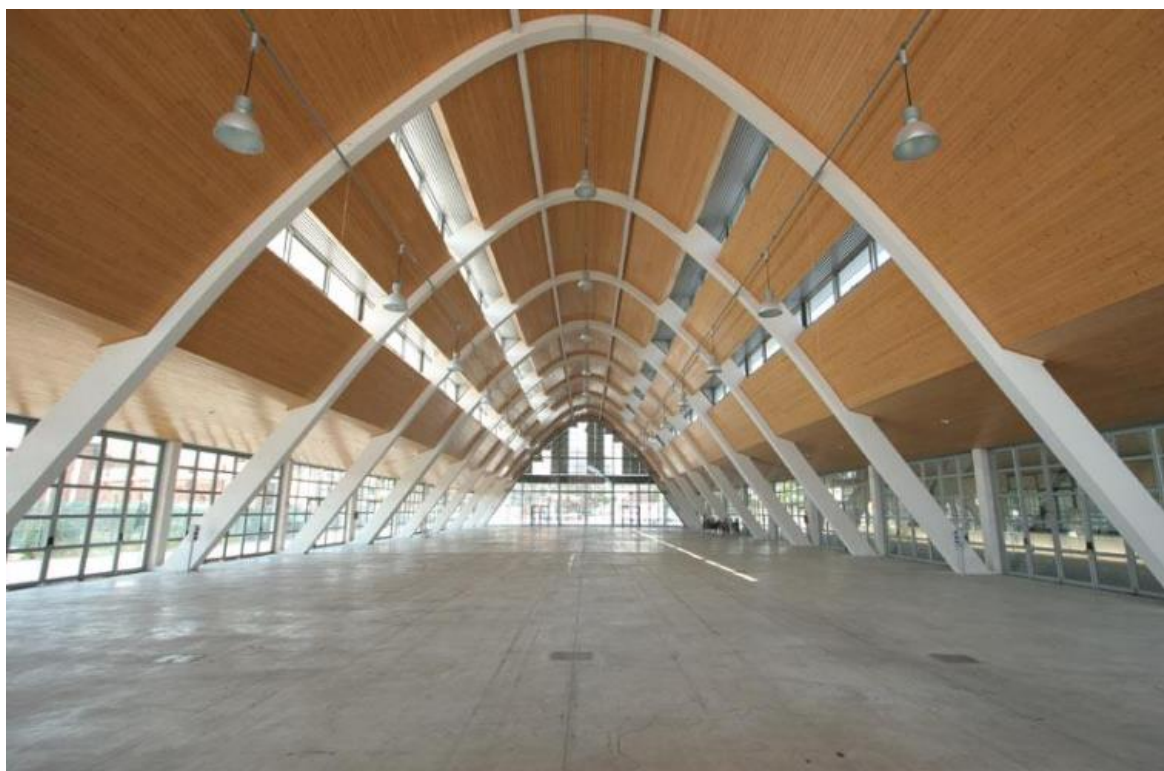
Figura 7.8 - Vista interna del Paraboloido Piccolo di Cerea dopo il recupero 1 .
