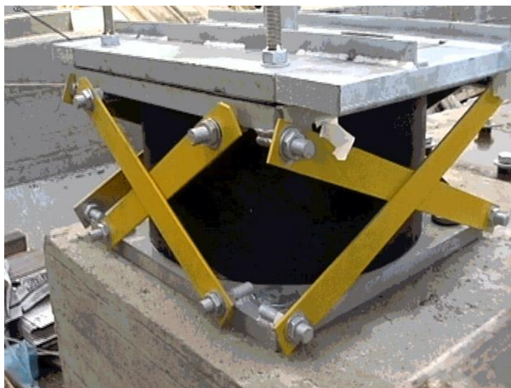
Figura 1.9. Isolatore posto alla base di un pilastro e munito di dispositivi di bloccaggio temporanei.
