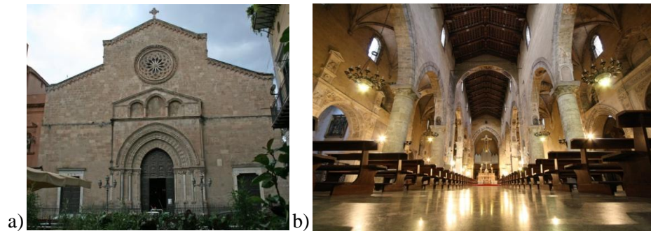
Figura 2.1. Basilica di San Francesco d'Assisi (Palermo). a) veduta esterna; b) veduta interna.
